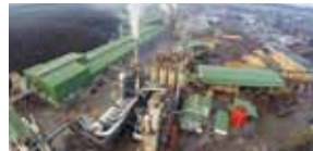
Romanya Kapı Paneli ve Yonga levha Tesisi 514.000 m 2 açık 140.000 m 2 kapalı alanda kapı paneli, yonga levha, melamin kaplı yonga levha ve mutfak tezgâhı üretimi yapılmaktadır.
