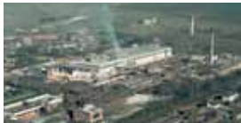
Bulgaristan Yonga levha Tesisi 189.000 m 2 açık 41.000 m 2 kapalı alanda yonga levha ve melamin kaplı yonga levha ve pelet üretimi yapılmaktadır.
